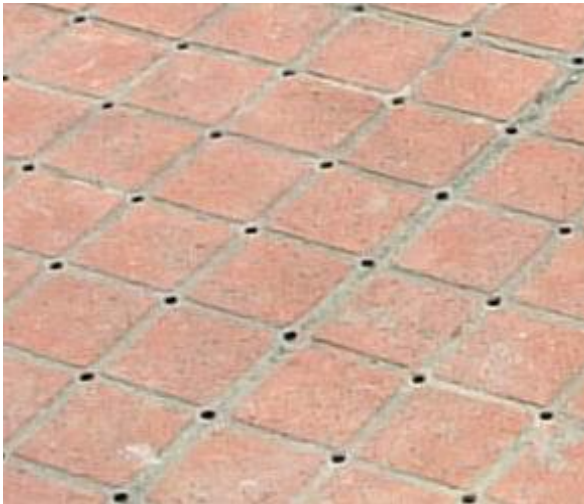
環保透水透氣混凝土鋪面
